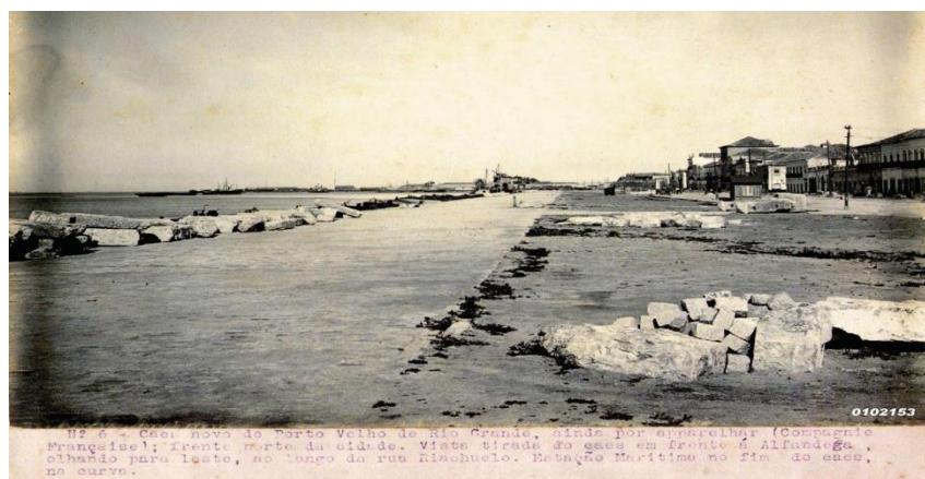
Figura 2 – Obras do cais do Porto Velho – sem data Fonte: em pesquisa
