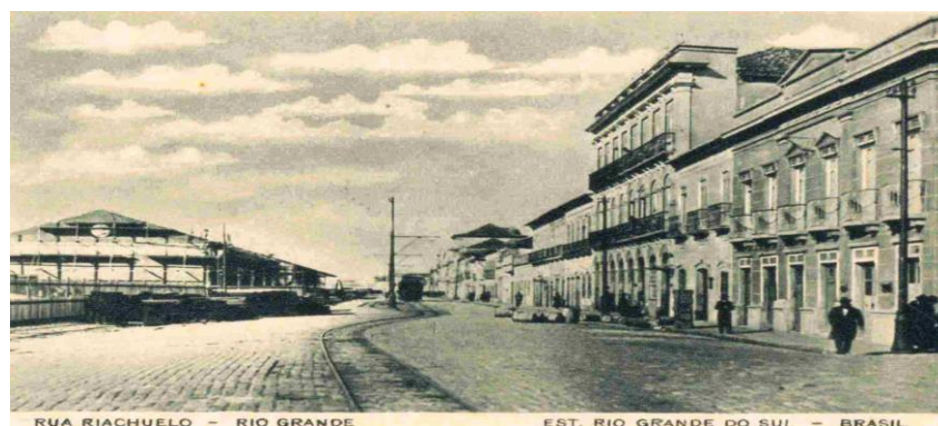
Figura 3 – Armazéns do Porto Velho em construção e Rua Riachuelo – 1915 Fonte: Acervo Fototeca Municipal Ricardo Giovannini
